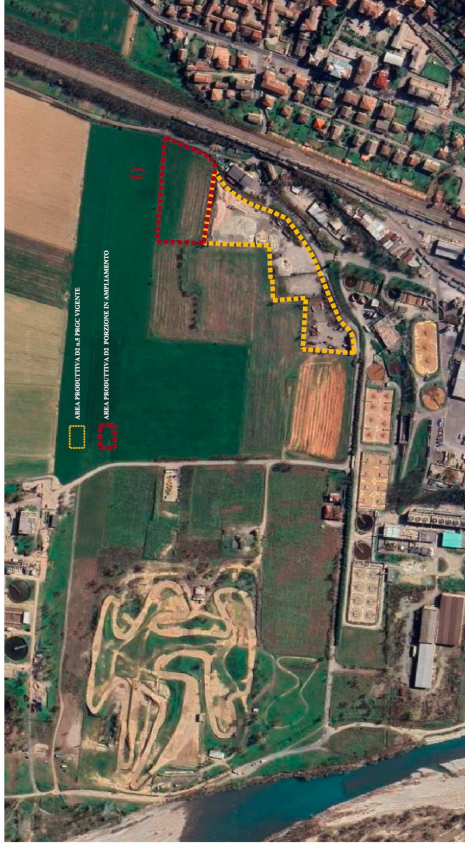
Veduta aerea dell'area
